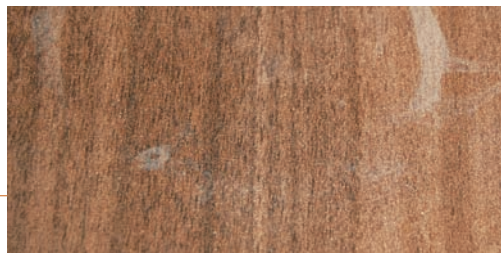
Laminatboden mit falscher Pflege: Schlieren, Trittspuren und leichte Aufquellungen.
